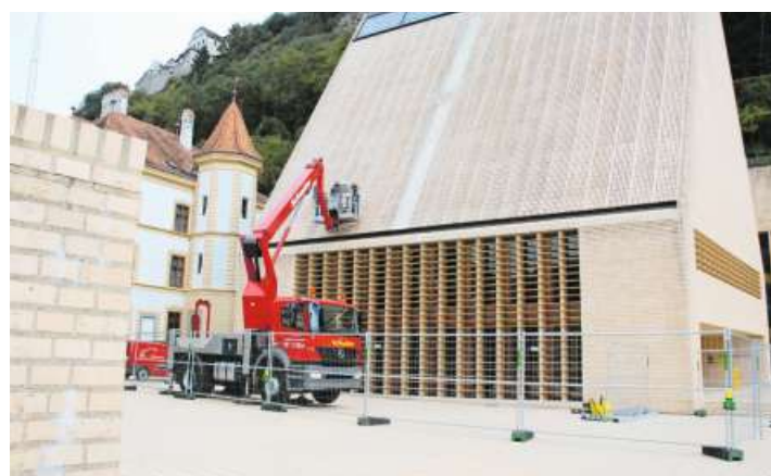
Erste Sanierungsarbeiten am Landtagsgebäude wurden bereits diesen Herbst durchgeführt.
